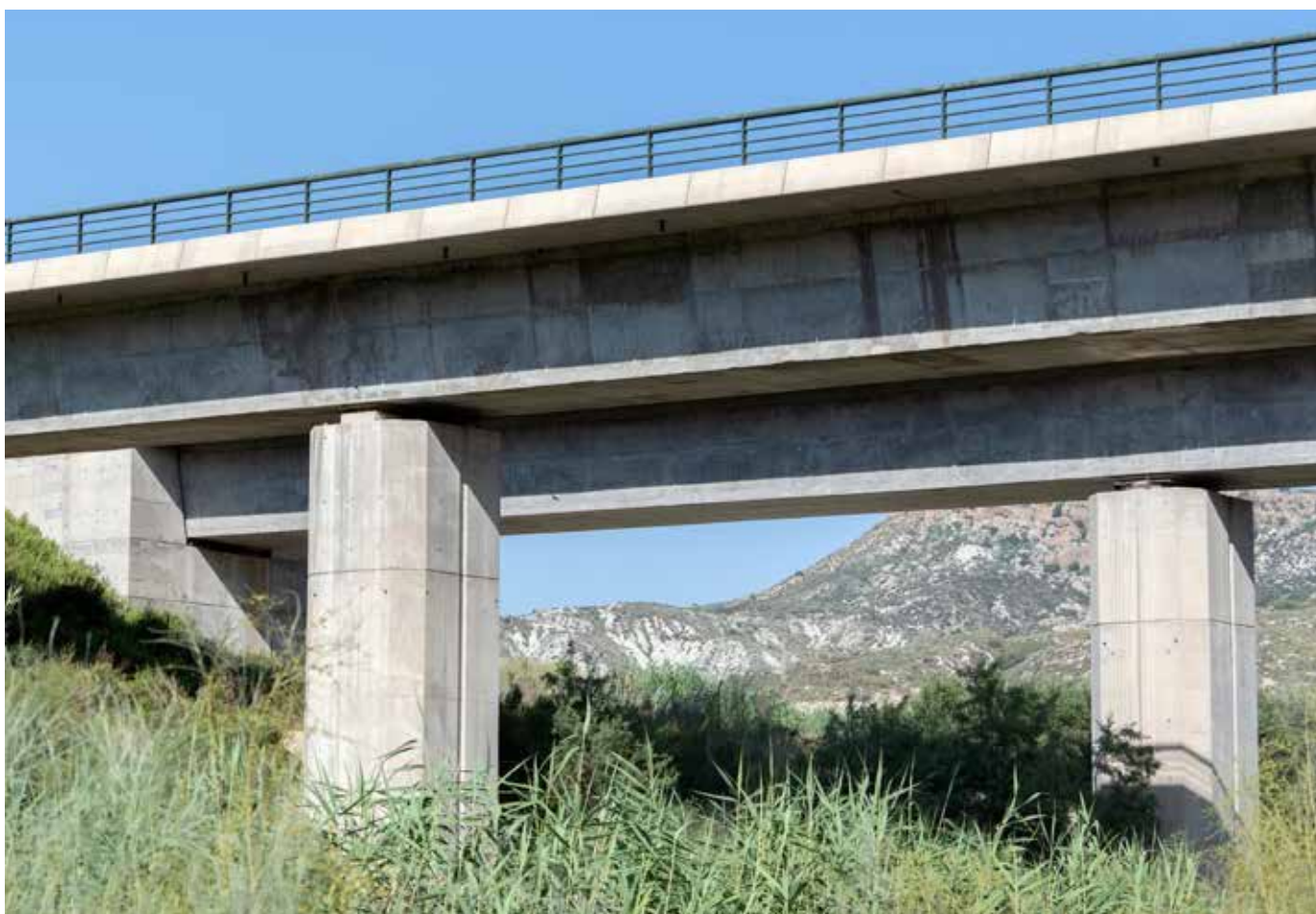
Detalle impostas en viaducto AVE tramo Los Gallardos, Almería (Andalucía).
