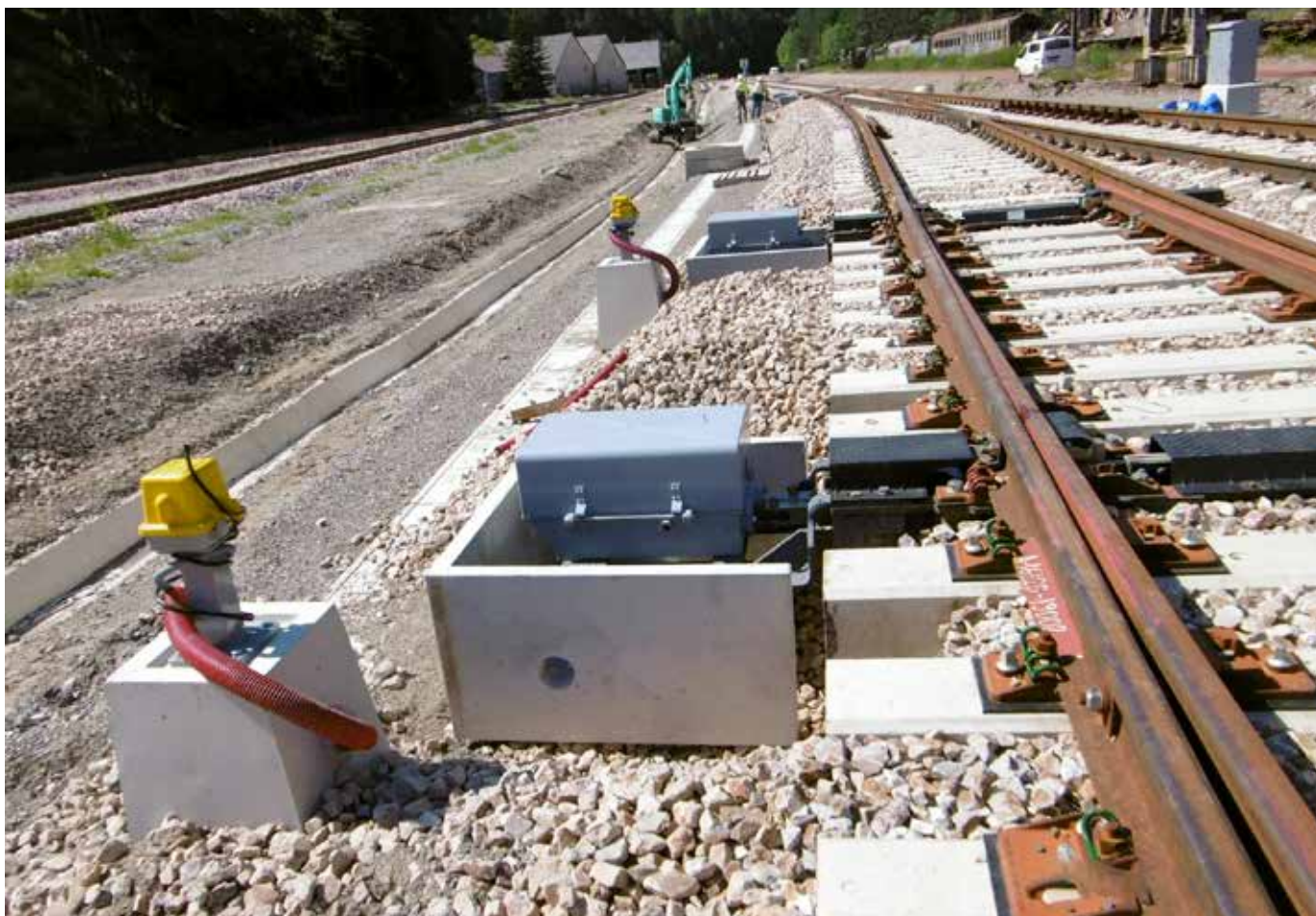
Cunas para motores en estación de Canfranc (Aragón).
