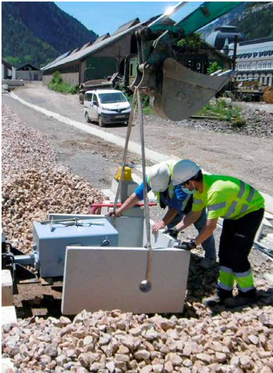
Instalación cuna de motores en estación de Canfranc, Huerca (Aragón).
