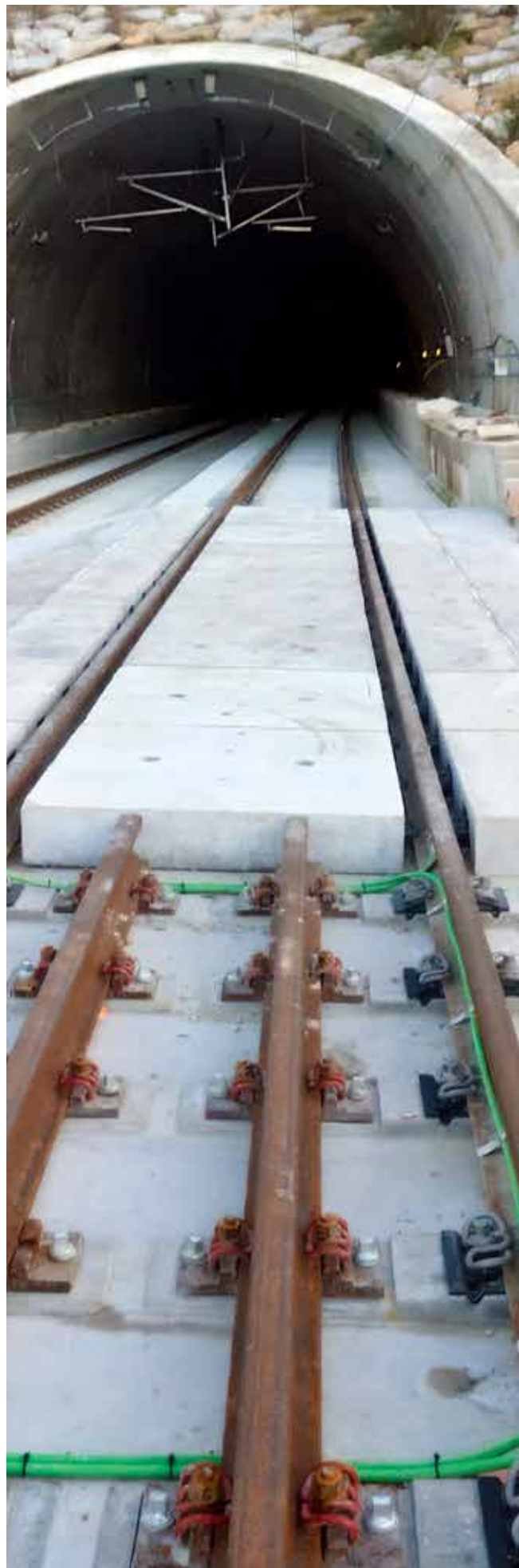
Paso bivial en acceso a túnel línea Campobeceros-Taboadela (Asturias).
