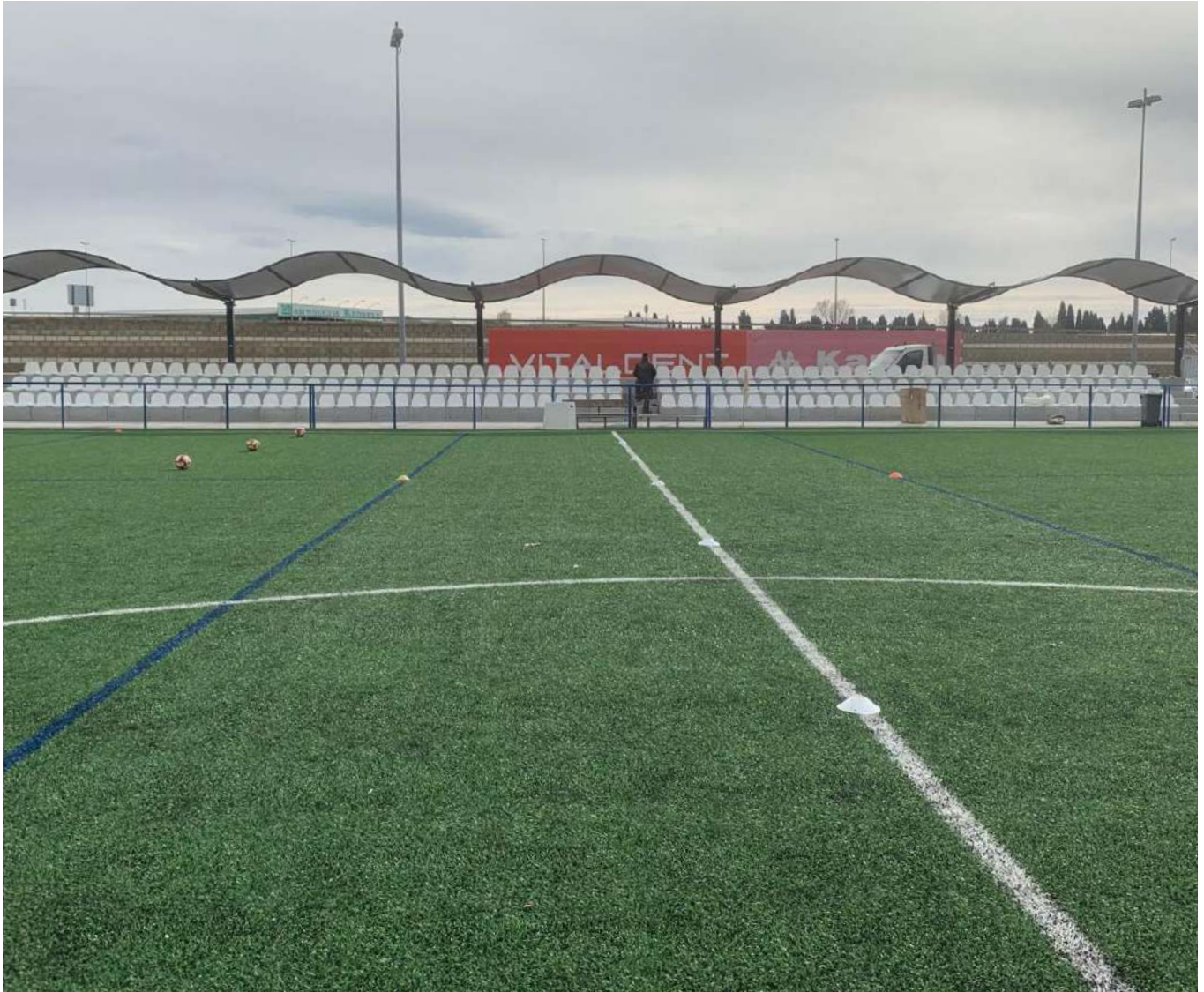
Fig. 16 y 17 | Conjunto de Graderio MR para el Campo de rugby, Puente Castro (León). Fuente: Elaboración propia.
