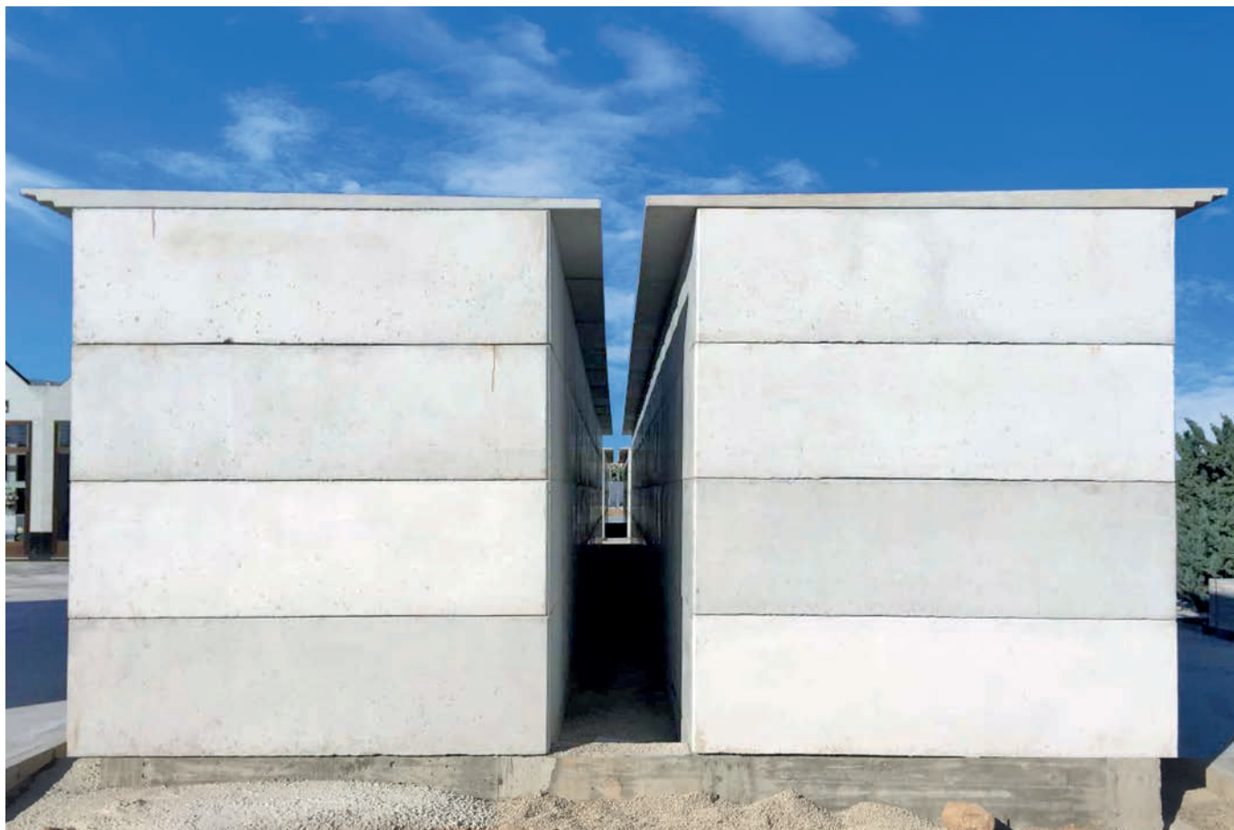
▲ Dos manzanas de nichos enfrentadas, con cámara de ventilación interior.
