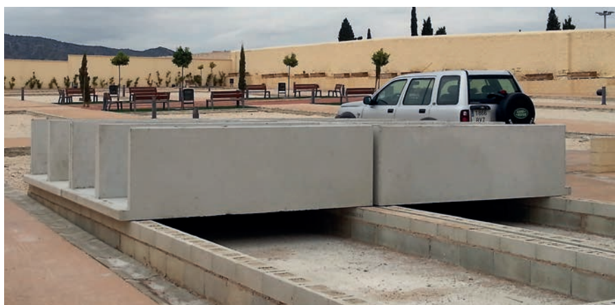
Murete construido a base de bloques rellenos de hormigón armado.
