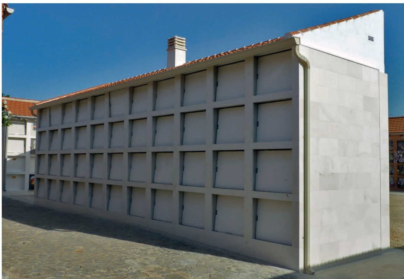
Revestimiento mediante colocación de piedra.
