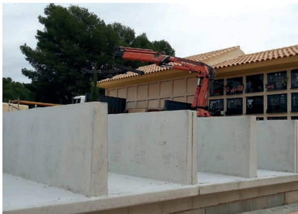
Colocación mediante grúa autocargante.
