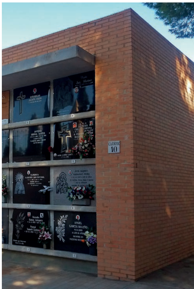
Revestimiento mediante ladrillo visto
