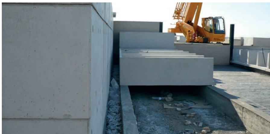
Apoyo mediante cimentación corrida.
