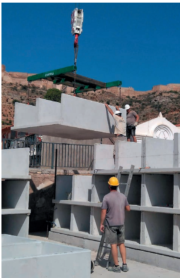
Colocación de prefabricados dobles.
