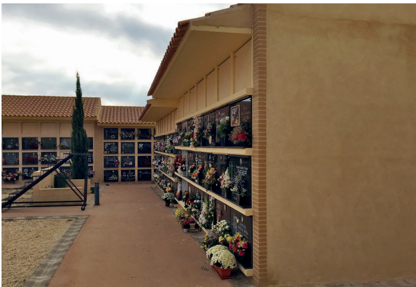
Revestimiento mediante colocación de bloques enfoscados con colorante crema
