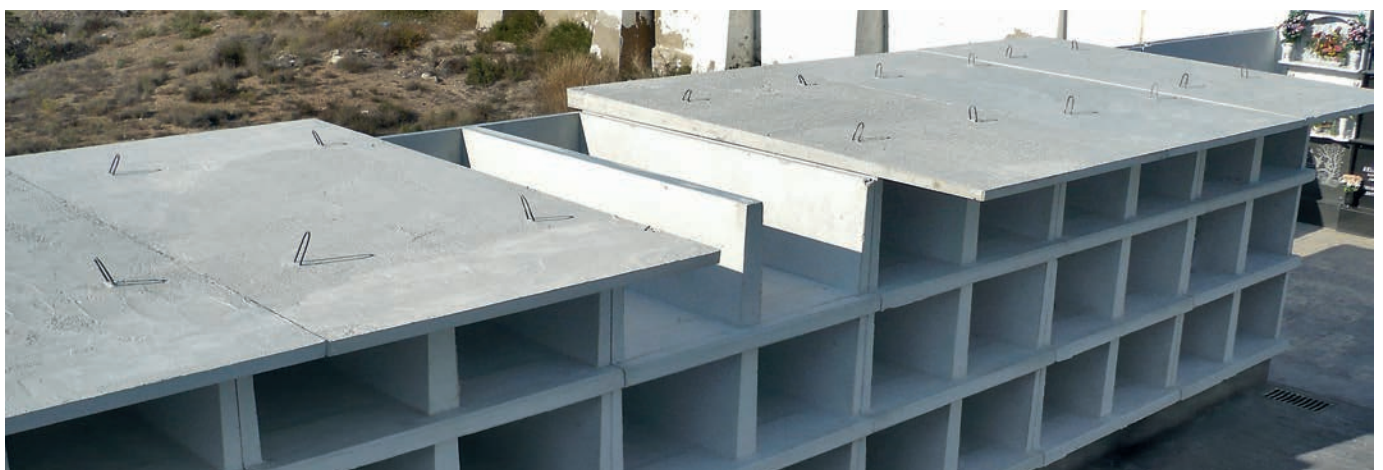
▲ Cerramiento de bloque de nichos mediante losa-techo de coronación inclinada
